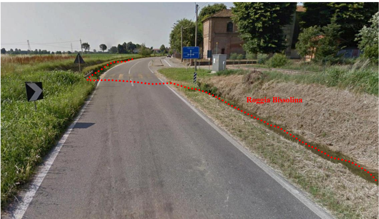
Attraversamento della SP 26 da parte della Roggia Bissolina con intubamento.
